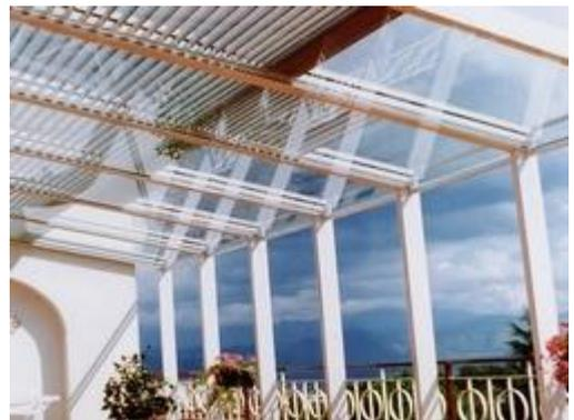
Le tettoie per terrazzo sono fissate nella maggior alle pareti dell'edificio tramite specifici perni che garantiranno un bloccaggio perfetto della tettoia anche in presenza di forti intemperie.
